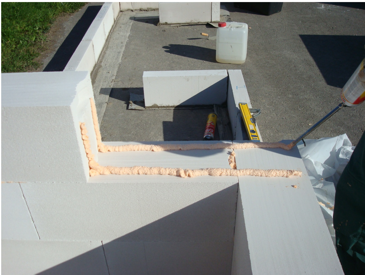
Рисунок 2. Процесс нанесения ППУ-клея на поверхность блоков в кладке
