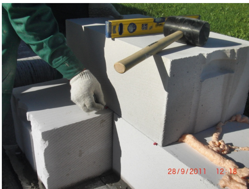
Рисунок 5. Процесс выравнивания блоков с использованием пластиковых клинообразных вставок
