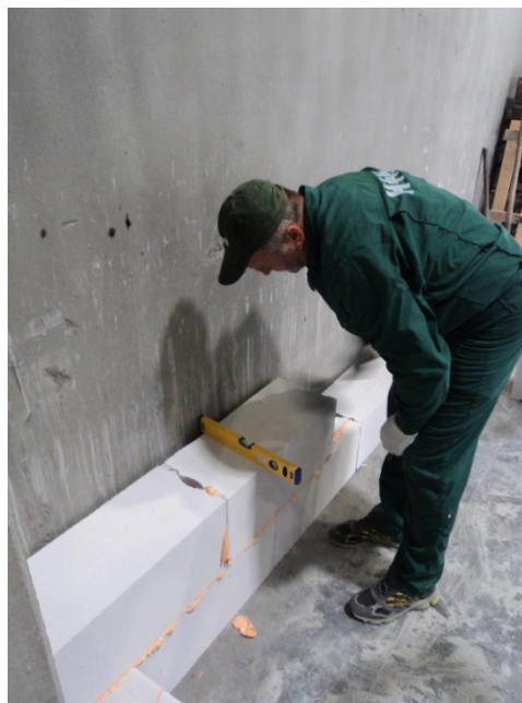
Рисунок 1. Монтаж экспериментального фрагмента кладки из газобетонных блоков на ППУ-клей
