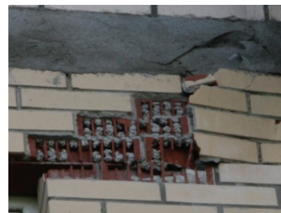
Рисунок 3. Заполнение щелей строительным раствором во время кладочных работ: а – выкрашивание кирпичей на торцевых участках плит перекрытий; б – выкрашивание кирпичей на участке примыкания к плите перекрытия
