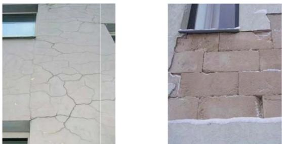
**Рисунок 9. Разрушение и отслоение штукатурного покрытия от газобетонной кладки [21]**
