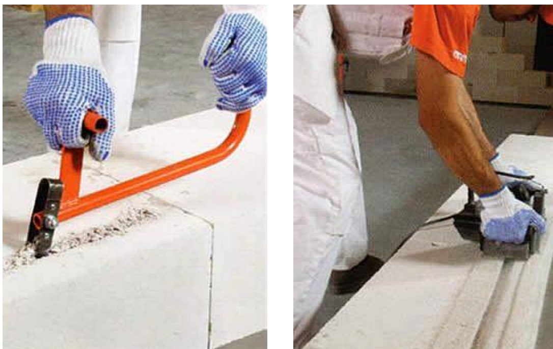
Рис. 1.19. Устройство канавки для арматуры ручным инструментом и фрезой
