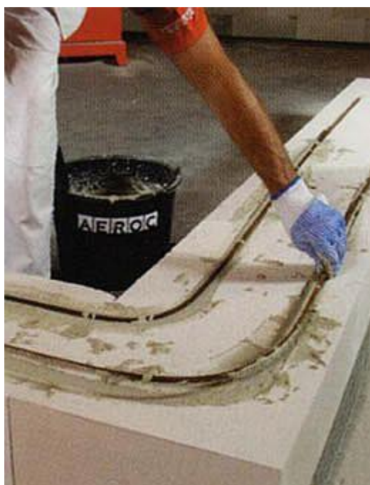
Рис. 1.20. Укладка арматуры в пазы блоков
