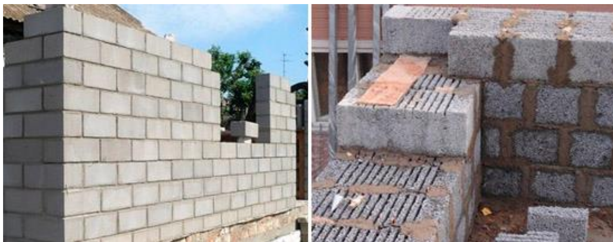
Рис. 1.17. Фрагменты стен из керамзитобетонных блоков
