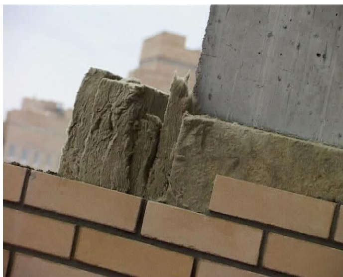
Рис. 1.7. Конструкция многослойной стены
