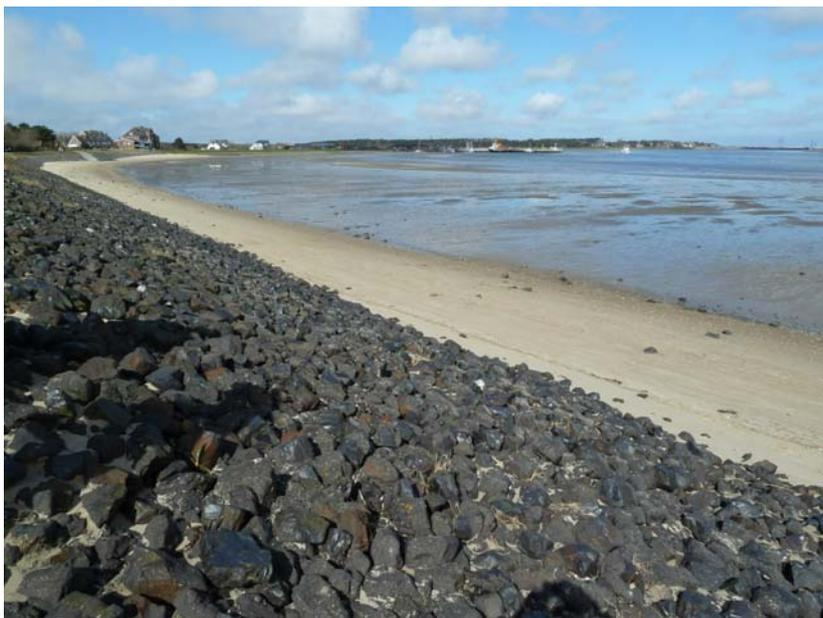
Рисунок 1. Берегозащитный откос с использованием технологии Эластокоаст на о. Амрум (Северное море, недалеко от Гамбурга)
