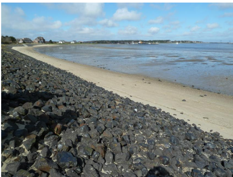
Рисунок 1. Берегозащитный откос с использованием технологии Эластокоаст на о. Амрум (Северное море, недалеко от Гамбурга)
