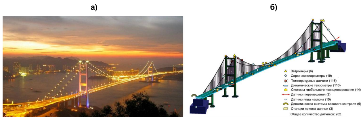
Рисунок 1. Мост Цинма в Гонконге: а – внешний вид; б – места расположения датчиков [6]
