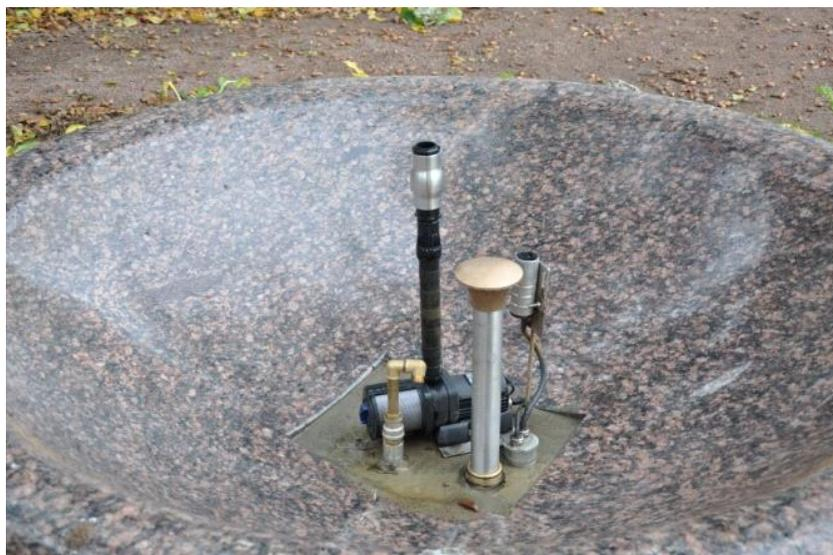
Рис. 1. Конструкция фонтана
