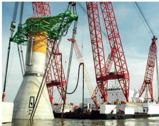
Рисунок 11. Конусообразная форма опорного основания [30]
