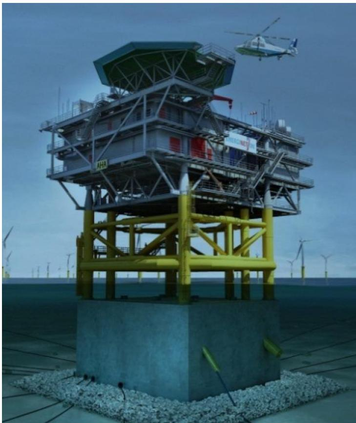
Рисунок 3. Проект сооружения с защитой из каменной наброски [24]
