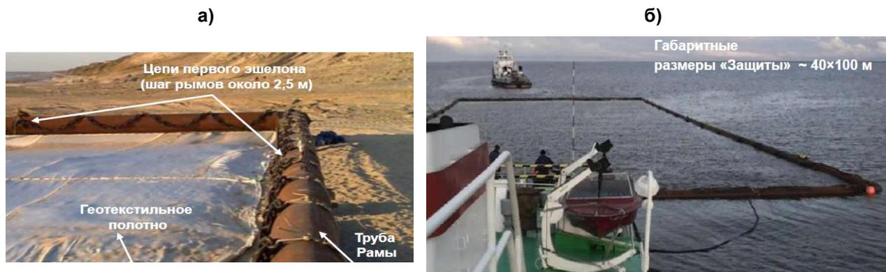
**Рисунок 7. Общий вид защиты из геоткани с трубными рамами и цепями: а – перед транспортировкой на место эксплуатации; б – подготовка перед погружением [1]**
