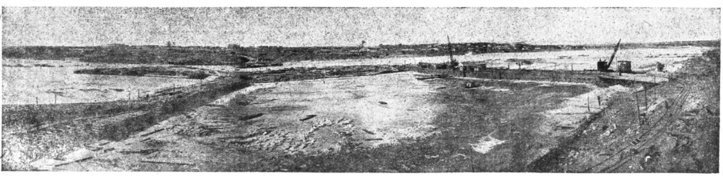
Вид котлована левого протока. Замыкает от юга котлован так называемый „Большой остров“. На верховой перемычке работают два американских паровозных края „Кедустріал“ по забивке шпунта. Высокое здание над гондом изюмской перемычки — управление главного инженера, левее — водоснабженная башня, еще левее — механ. мастерские. Ниже — изюмская перемычка правого протока
