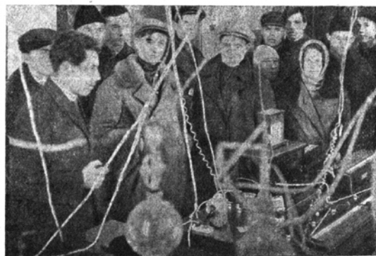
В электроизмерительной лаборатории Главного здания
