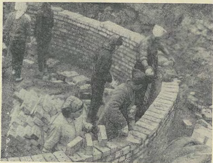
На строительстве пожарного резервуара.
