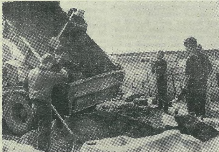
На два месяца студенты станут каменщиками, бетонщиками, плотниками.
