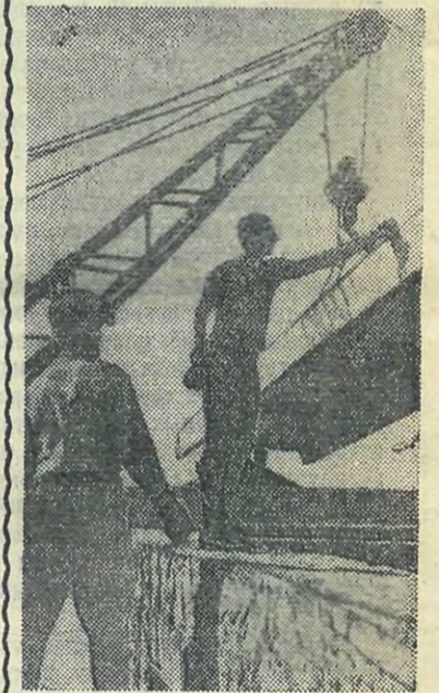
На строительной площадке. Монтаж перекрытия.
