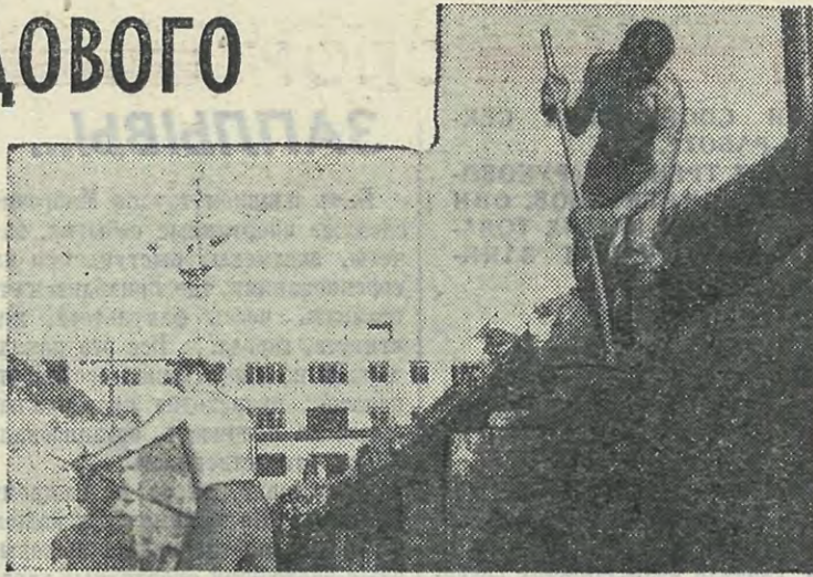
НА СНИМKE: Вуктыл. Бойцы ССО «Алмаз» на строительстве теплотрассы в новом поселке.
