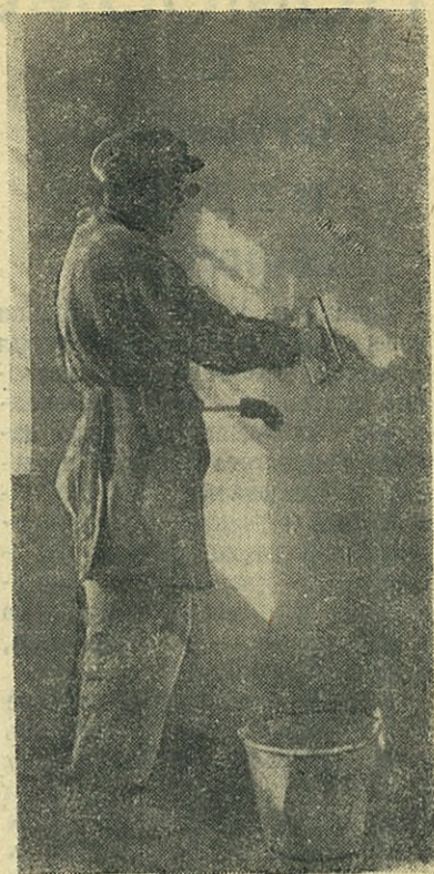
Передовик восстановления нашего института шпукатур Г. И. Бучкин. Фото Д. Трахтенберга
