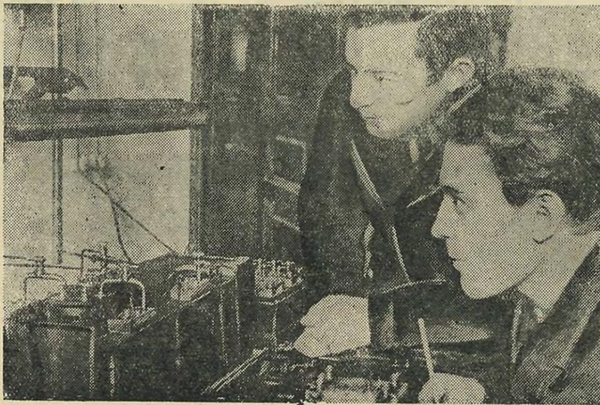
Студенты А. Басов и М. Виленский в лаборатории точных измерений измеряют сопротивление интерполяционным методом на мостике Уитстона
