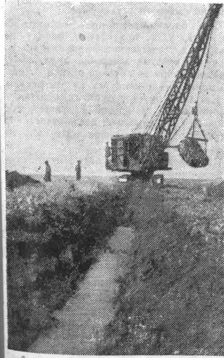
На снимке—выемка грунта экскаватором на рисовых полях. Конструировать, строить и эксплуатировать экскаваторы учатся студенты механического факультета
