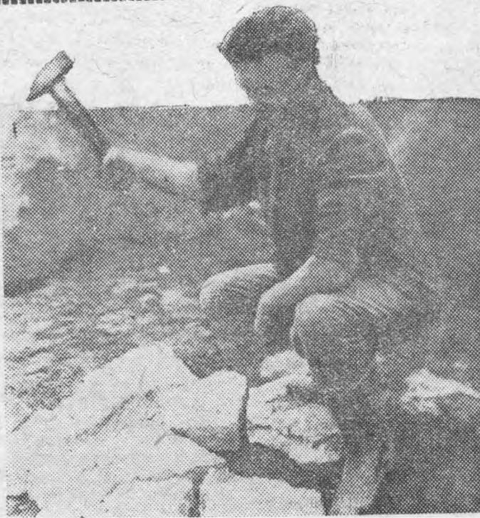
Комсомолец-ударник т. Анулов на стройке понижающей подстанции
