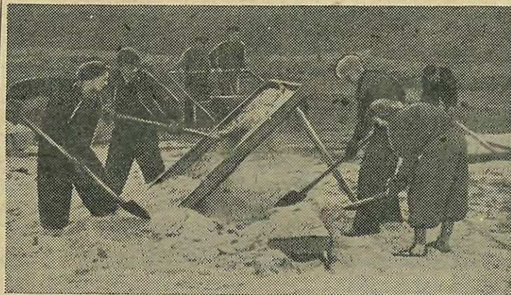
На строительстве стадиона.
