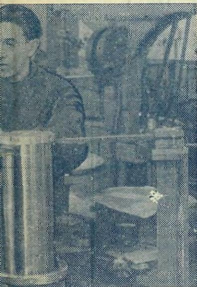
На снимке: слесарь механических мастерских научного отдела В. Л. Железнов заканчивает монтаж макета вибрационного стенда.
