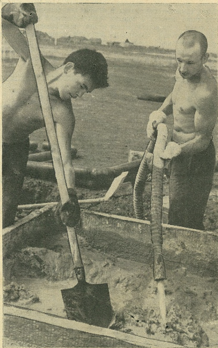
Студенты на целине стали строителями.
