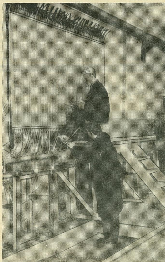
Студент группы 413 Ю. Черняев и дипломант Ю. Богданов проводят опыт на модели проточной части электромагнитного насоса в лаборатории гидроэнергетики кафедры использования водной энергии.
