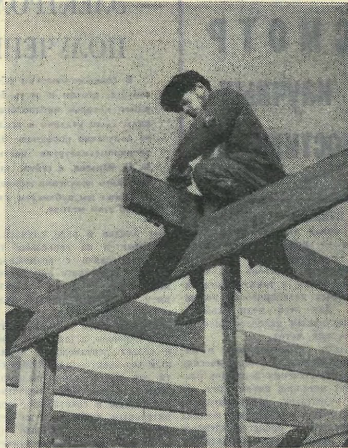
На строительстве бытового помещения школы-интерната.
