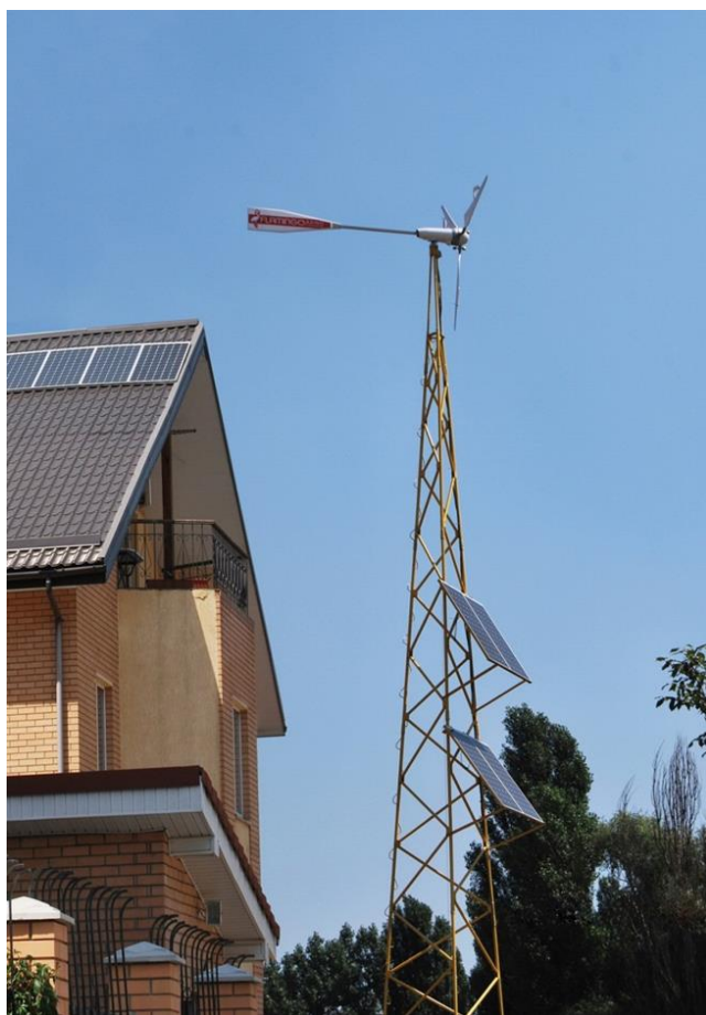
Рисунок 1.31. Энергокомплекс ВИЭ-АС для индивидуального поселения
