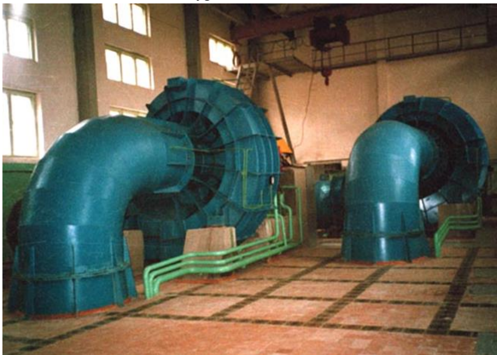
Рис. 1.25. Здание приплотинной Акбашской МГЭС с двумя гидроагрегатами ГА8 мощностью по 500 кВт после реконструкции (ЗАО МНТО ИНСЭТ)
