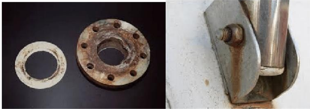
Рисунок 3 – Внешний вид щелевой коррозии
