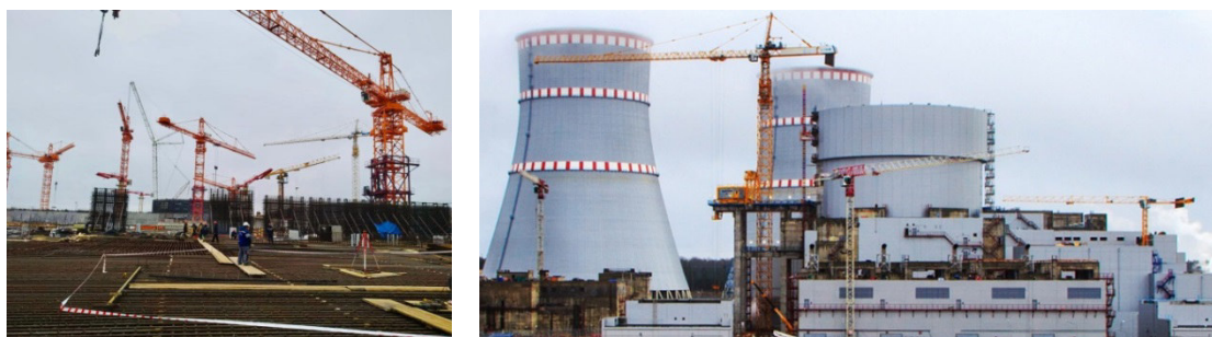
Рис. 5. Слева – 2-й энергоблок Курской АЭС-2 с реактором типа ВВЭР-ТОИ (15.04.2019 г.), справа – строящийся 2-й энергоблок Ленинградской АЭС-2 с реактором ВВЭР-1200 (02.04.2019 г.)
