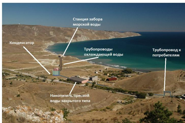
Рис. 3. Общий вид блока W-CONDENSER с конденсатной станцией
