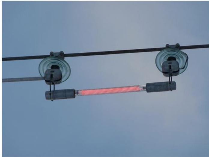
Рис. 1. Лампа BALISOR с антенной, на высоковольтном проводе
