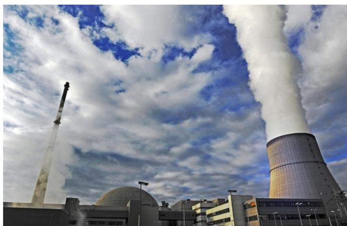
Рис. 2. Вертикальная теплая воздушная струя из градирни АЭС, действующая по схеме аэротермического кулера при отсутствии приземного ветра
