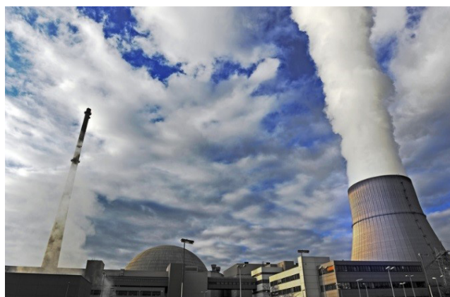
Рис. 2. Вертикальная теплая воздушная струя из градирни АЭС, действующая по схеме аэротермического кулера при отсутствии приземного ветра Fig. 2. A vertical warm air jet from a nuclear power plant cooling tower, operating according to the scheme of an aerothermal cooler in the absence of surface wind
