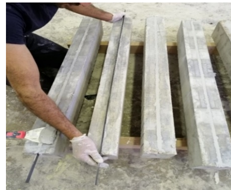
(d) Installation of CFRP strips in groove
