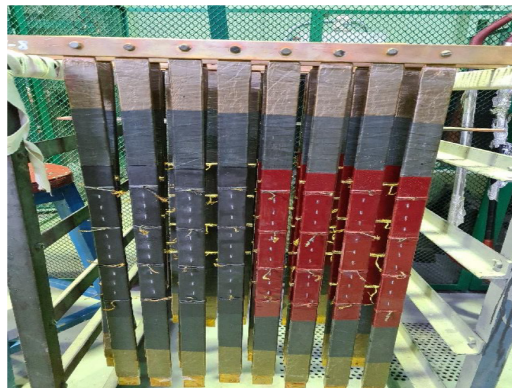
Рис. 6. Фотография исходного состояния макетов с нанесенными искусственными дефектами в полупроводящем покрытии конструкций: полупроводящая лента + полупроводящая эмаль (серый цвет покрытия-слева) и полупроводящая лента + полупроводящая эмаль + защитное диэлектрическое покрытие (красный цвет покрытия – справа)
