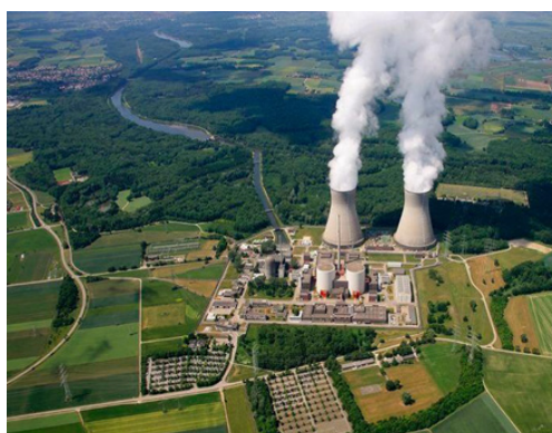
Рис. 3. Подъем вертикально-цилиндрической струи теплого воздуха из башенных градирен в тропосферу Fig. 3. Rise of a vertical cylindrical stream of warm air from cooling towers into the troposphere
