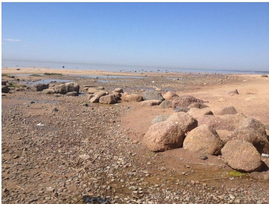
Рис. 1. Общий вид разрушенных бун
