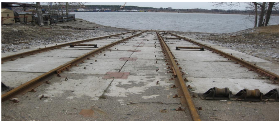
Рис. 1. Вид сверху на существующие судовозные пути судостроительного завода
