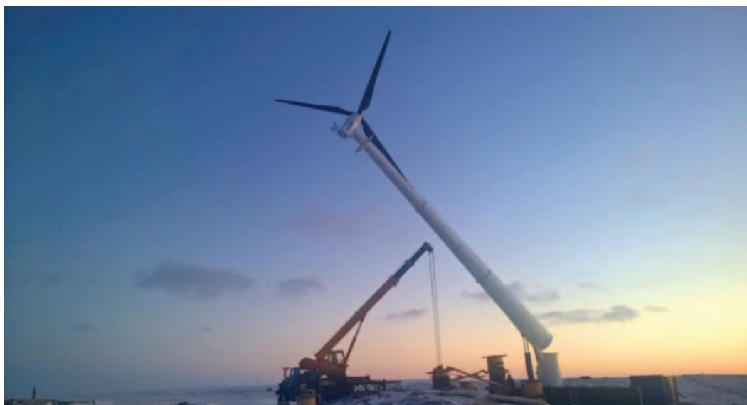
Рис. 9. Бескрановый монтаж адаптированной ВЭУ на ВДЭС Амдерма [5]
