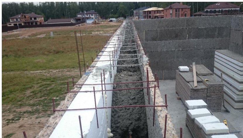
Рис. 1. Заливка бетона в опалубку
