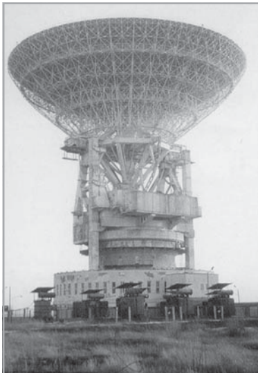
Антенна для дальнего космоса. Диаметр ее зеркала немногим меньше футбольного поля, а управлять ею нужно с ювелирной точностью
