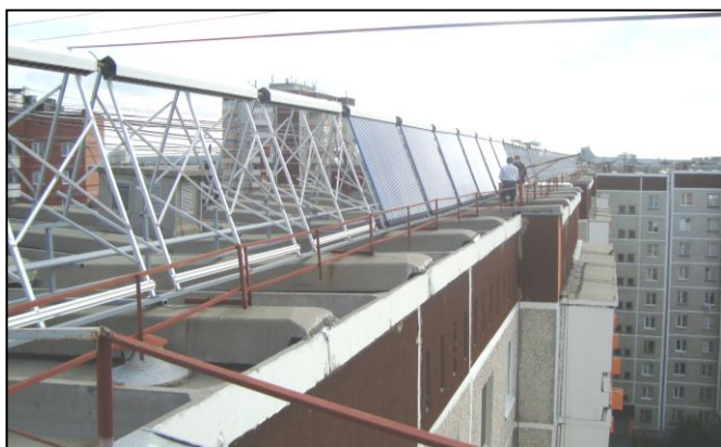
Рисунок 26. Схема подключения вакуумных СК к штатной системе отопления и ГВС 10-тиэтажного дома (Екатеринбург)
