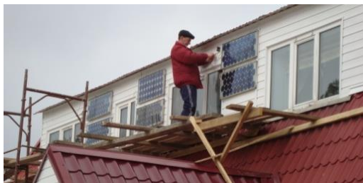
Рисунок 14. Монтаж ФЭП с вертикальным расположением на объекте «Энергоэффективный дом»
