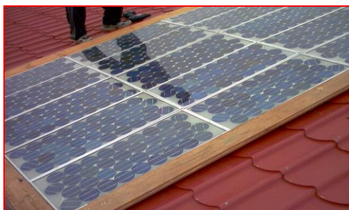
Рисунок 15. Фото ФЭС N_{\text{пик}} 420 \text{ Вт} и схема коммутации ФЭП
