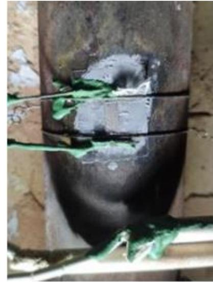
Рисунок 9 – Схема расположения ГГДТП в топке котла ДКВр 10/13 (а), пример установки ГГДТП на экранные трубы (б)
