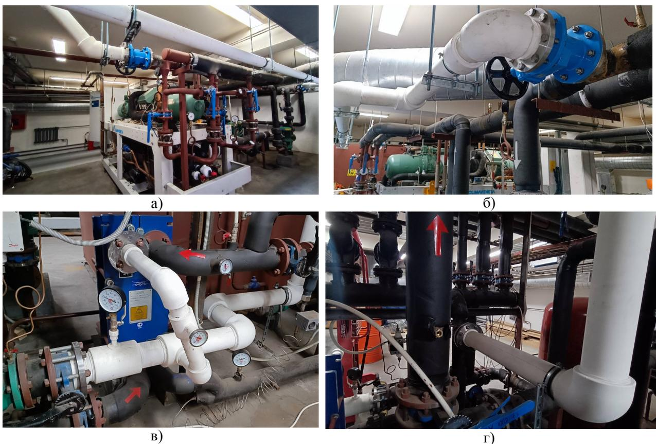
Рисунок 3 – Врезка в систему утилизации теплоты конденсации рабочего агента и гидравлическую систему циркуляции теплоносителя тепловентиляторов ледовых арен: а) – врезка задвижки в трубопровод системы утилизации (поз.10 рис.3); б) – врезка задвижки в обратный трубопровод системы утилизации (поз.7 рис.3); в) – врезка в трубопровод подачи теплоносителя на тепловентиляторы (поз.13 рис.3); г) – врезка в обратный трубопровод теплоносителя от тепловентиляторов (поз.12 рис.3)
