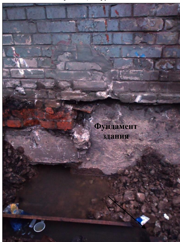
Фото 4. Фотофиксация фундаментов здания
