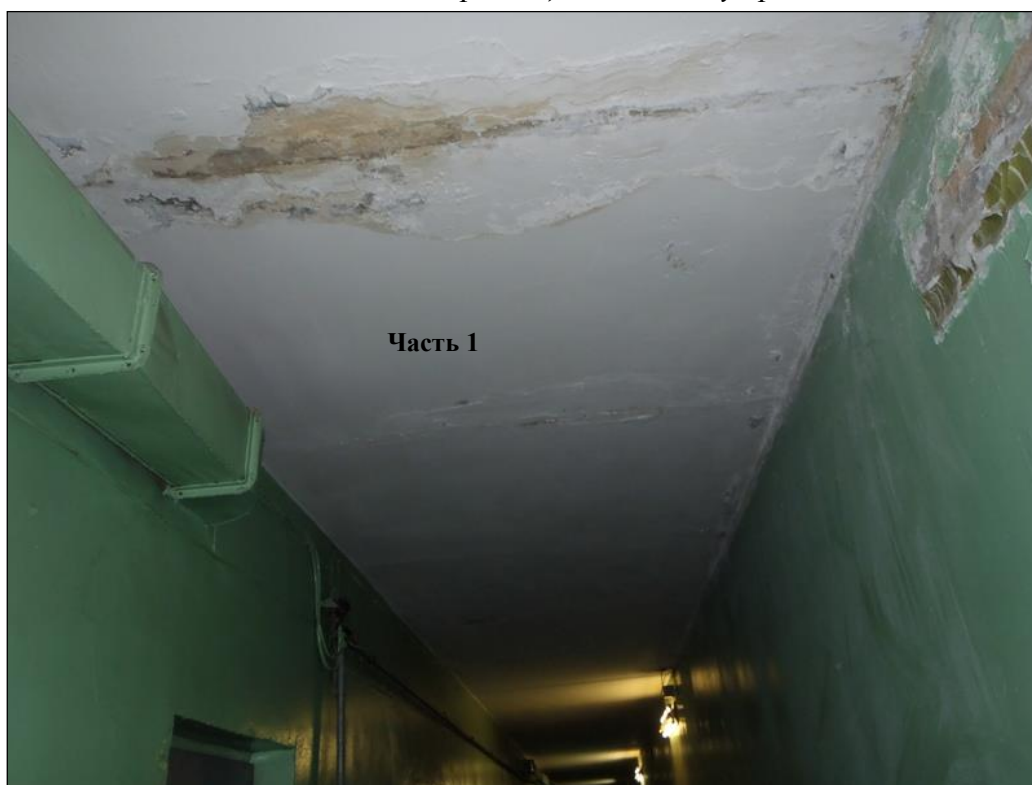
Фото 6. Фотофиксация здания внутри (3 этаж)
