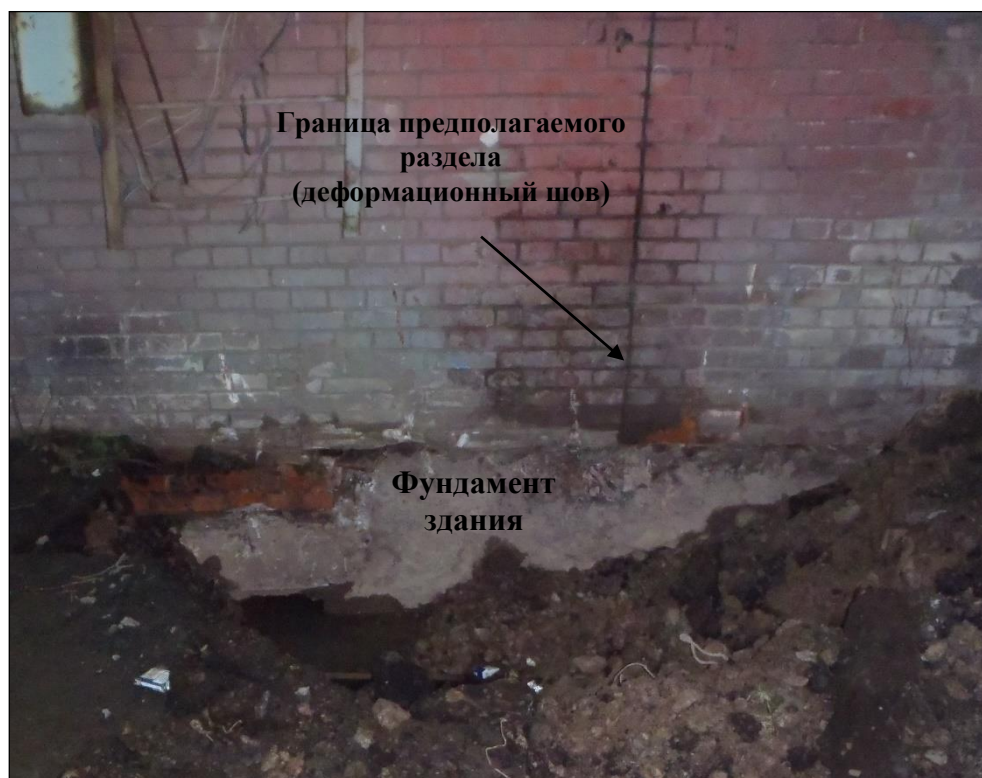
Фото 3. Фотофиксация фундаментов здания
