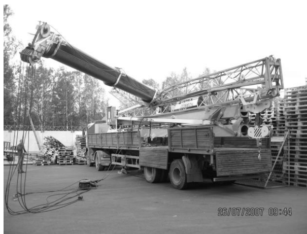
Рис.4.9. Авария автомобильного крана в результате разрушения неповоротной рамы
