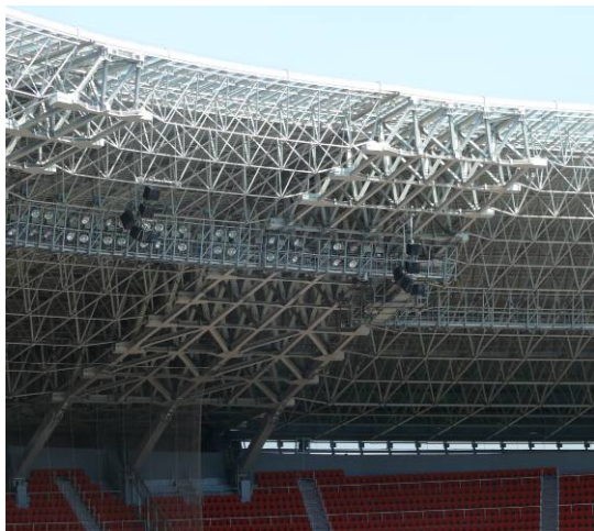
Рис. 5.8 Пространственная консольная ферма покрытия большого сечения
