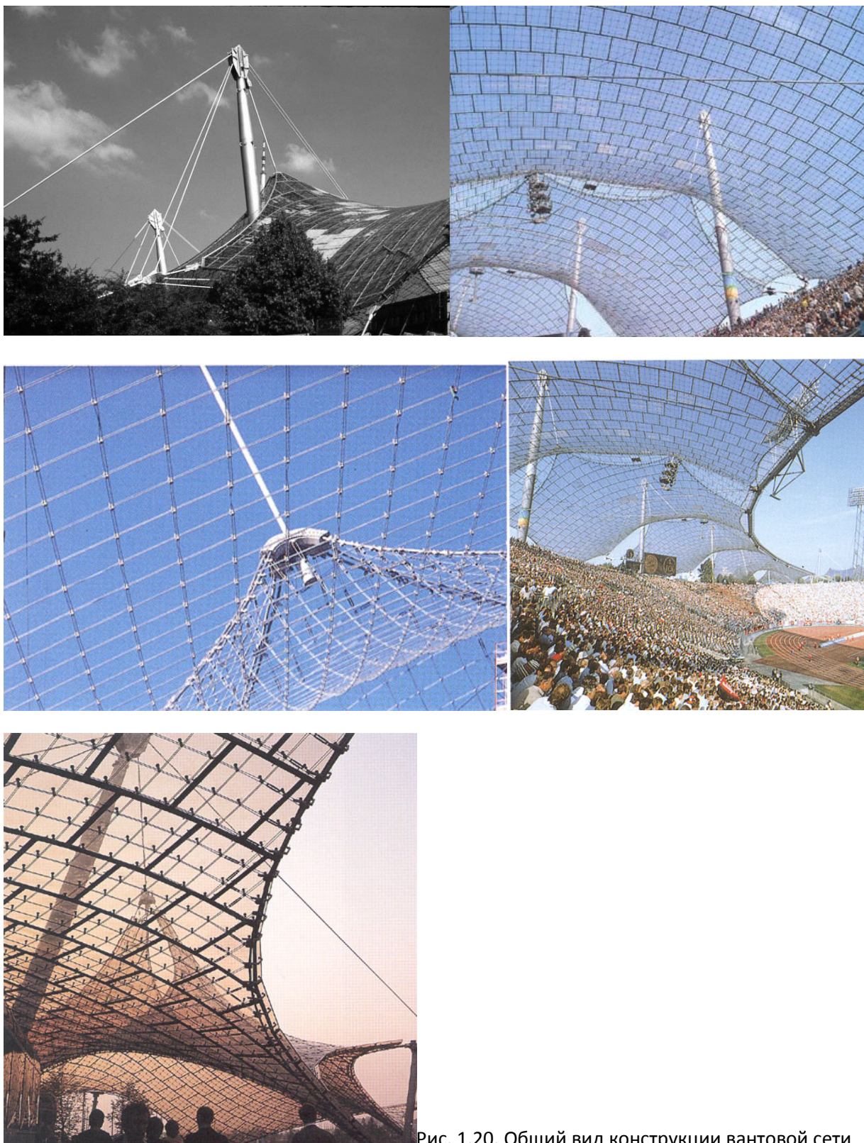
Рис. 1.20. Общий вид конструкции вантовой сети
