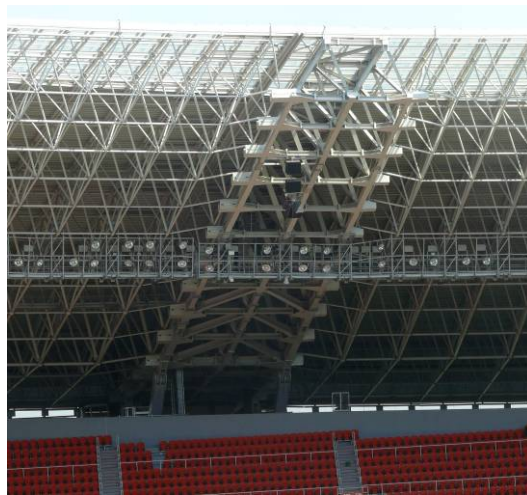
Рис. 5.9 Пространственная консольная ферма покрытия меньшего сечения
