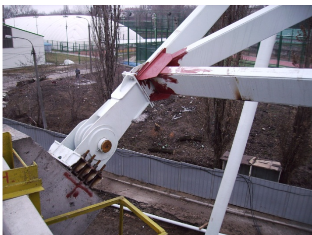
Рис. 1.12 Монтаж основных элементов покрытия: а - балансирующий узел крепления оттяжек ферм к железобетонным конструкциям трибун; б - установка системы подстропильной и распределительных ферм на южной трибуне; в - укрупнительная сборка фермы; г - узел опирания ферм навеса над VIP – корпусом; д - шарнирный башмак опирания распределительной фермы; е - сборка фланцевого узла фермы
