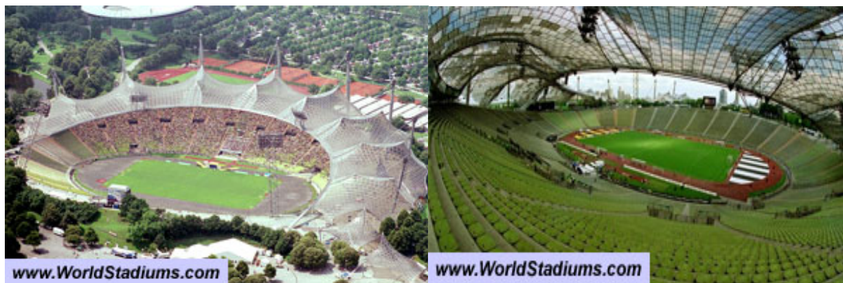
Рис. 1.20. Виды на конструкцию покрытия стадиона снаружи и изнутри
