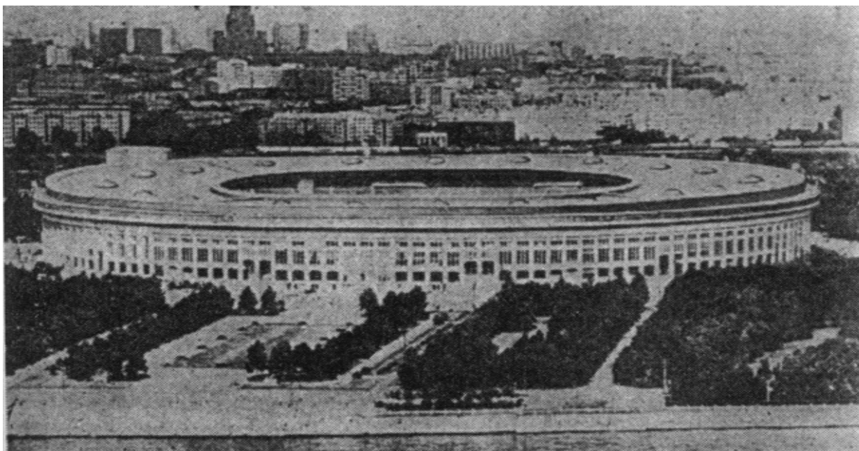
Рис. 1. 25. Козырек в виде сферической мембраны: 1 – мембрана толщиной 4 мм; 2 – наружный сталебетонный контур; 3 – внутренний стальной контур; 4 – стабилизирующие фермы; 5 – трибуны
