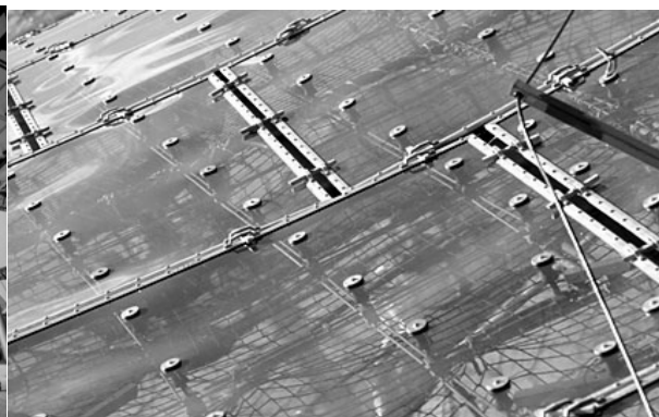
Рис. 1.24. Узлы крепления кровельных панелей
