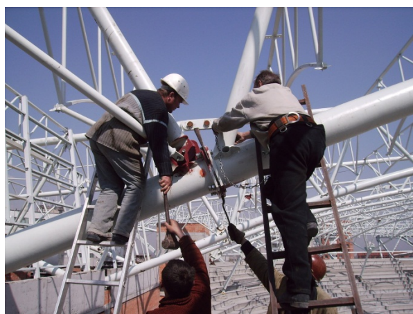
Рис. 1.12 Монтаж основных элементов покрытия: а - балансирующий узел крепления оттяжек ферм к железобетонным конструкциям трибун; б - установка системы подстропильной и распределительных ферм на южной трибуне; в - укрупнительная сборка фермы; г - узел опирания ферм навеса над VIP – корпусом; д - шарнирный башмак опирания распределительной фермы; е - сборка фланцевого узла фермы
