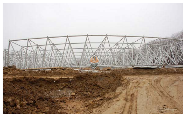
Рис. 5.11 Трапециедальный блок структурного покрытия перед монтажом
