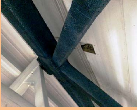
Стальные конструкции с огнезащитной гибкой сеткой «ПРОМИЗОЛ-СТК-Мет»
