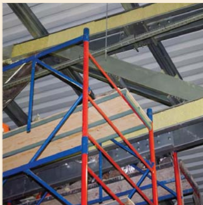
Процесс монтажа огнезащиты ЛСТК
