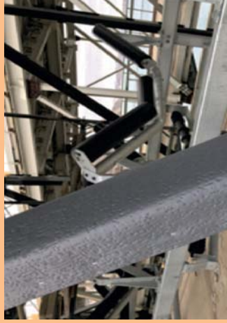
Стальные конструкции с огнезащитной гибкой сеткой «ПРОМИЗОЛ-СТК-Мет»
