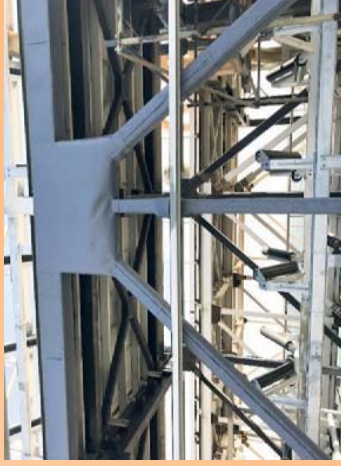
Стальные конструкции с огнезащитной гибкой сеткой «ПРОМИЗОЛ-СТК-Мет»
