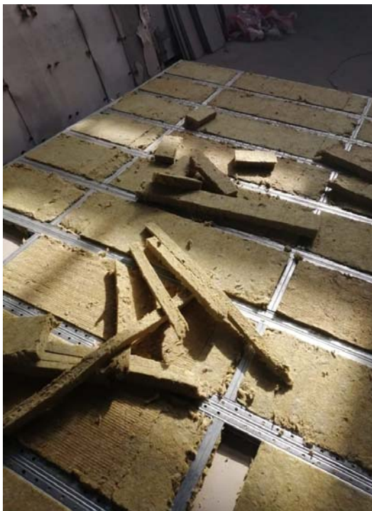
Рисунок. 4.4. Пример возможного заполнения конструкции минеральной плитой
