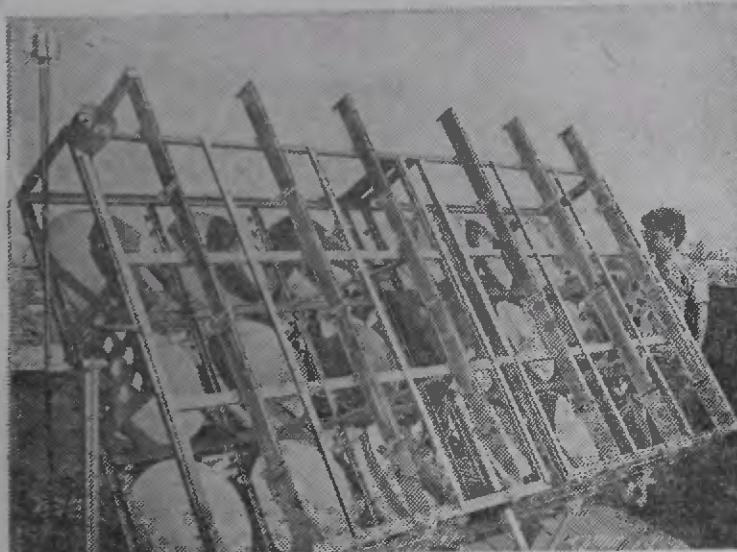
Рис. 94. Современная солнечная батарея. Вогнутые отражатели концентрируют солнечное излучение на элементы, основу которых составляет контакт GaAs с тройным полупроводниковым соединением GaAlAs
