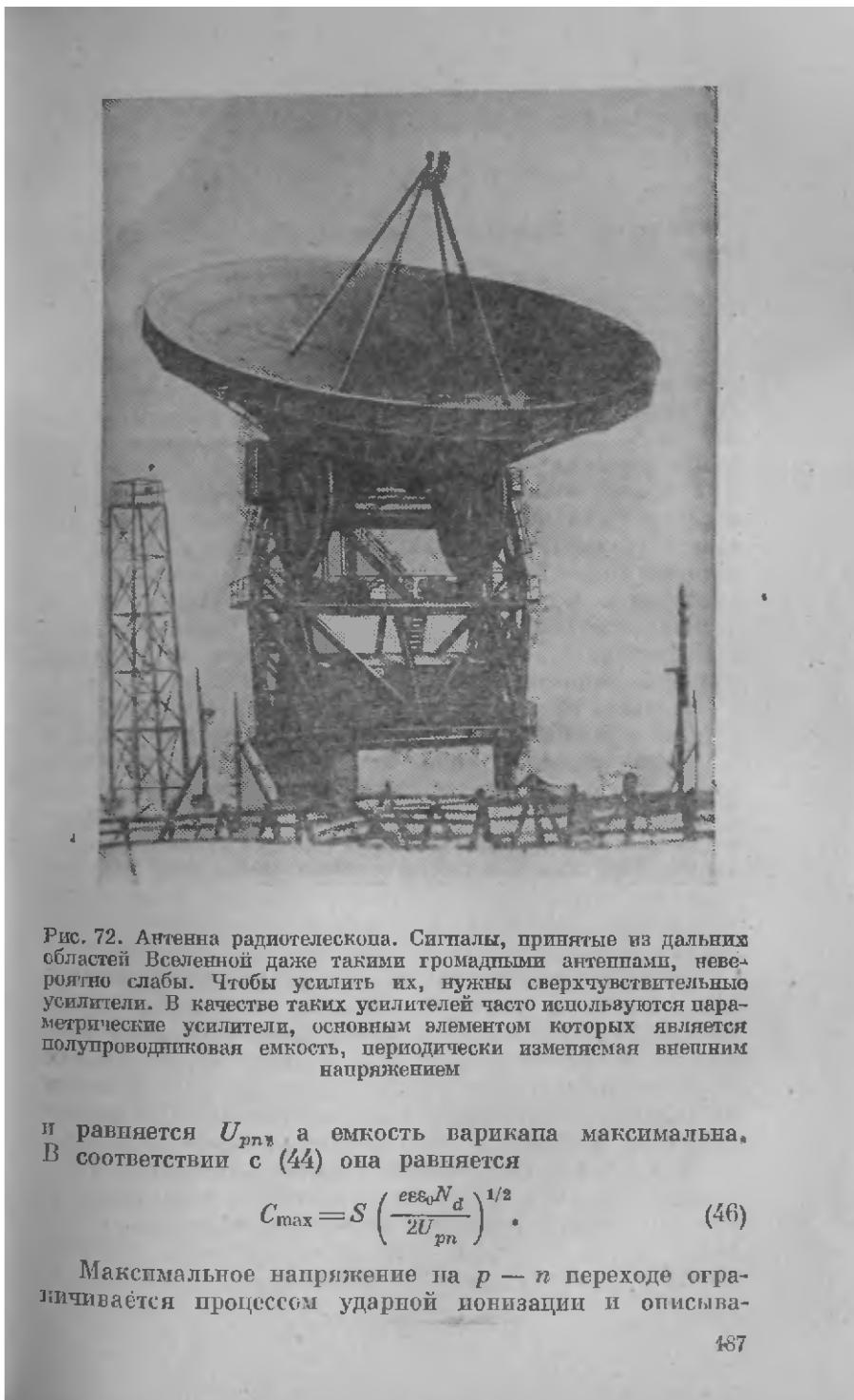
Рис. 72. Антенна радиотелескопа. Сигналы, принятые из дальних областей Вселенной даже такими громадными антеннами, невероятно слабы. Чтобы усилить их, нужны сверхчувствительные усилители. В качестве таких усилителей часто используются параметрические усилители, основным элементом которых является полупроводниковая емкость, периодически изменяющаяся внешним напряжением
