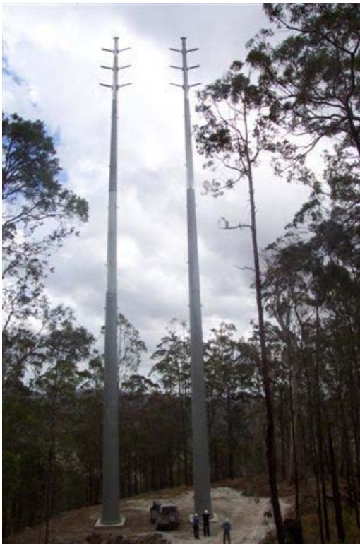
Две опоры высотой 65,0м напряжением 132 кВ установленные в Австралии. 2000г.
