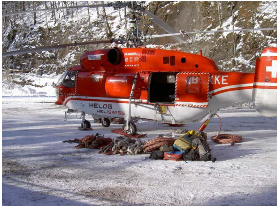
Рис. 9 Применение вертолета Ка-32 в электросетевом строительстве Швейцарии
