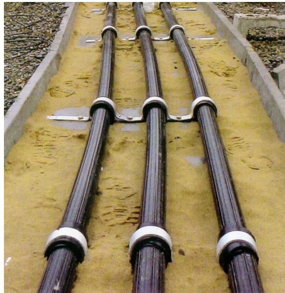
Рис. 4.9. Укладка кабелей с изоляцией из сшитого полиэтилена
