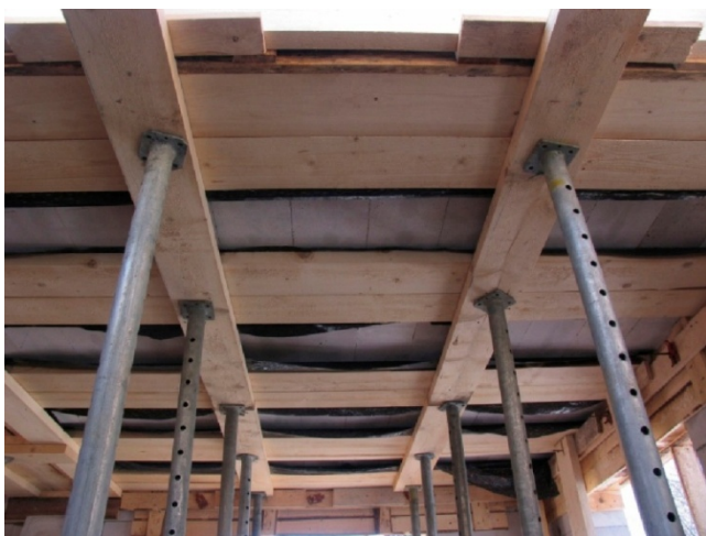
Рисунок 2. Схема устройства опалубки
