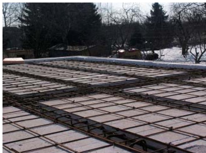
Рисунок 3. Укладка блоков на деревянный настил
