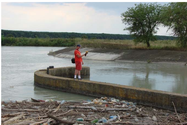
Рисунок 3. Обследование откосов шлюза-распределителя ГАЭС
